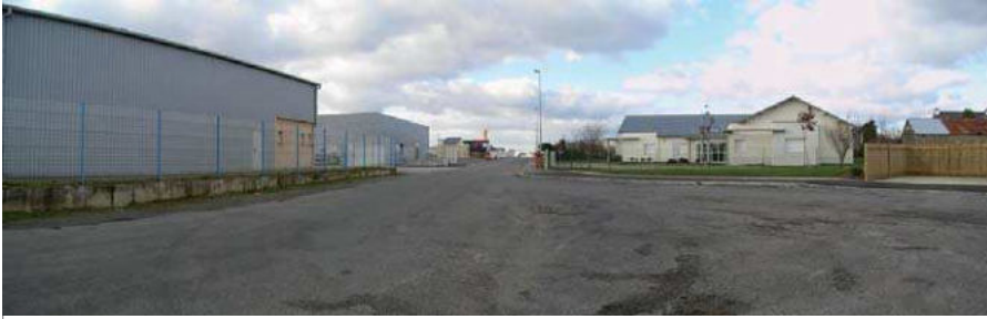
Jonction entre la zone artisanale en façade sur la RN 165 et les parcs de Kerhor
