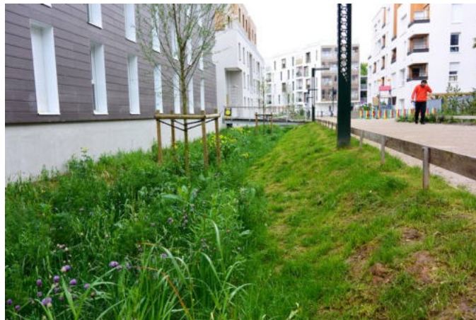
Noue Paysagère végétalisée, Ecoquartier à Palaiseau
