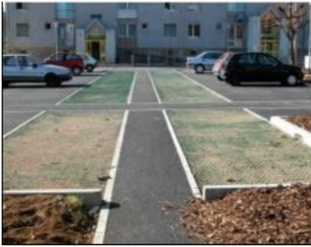
Exemple de parking réservoir à Albi
