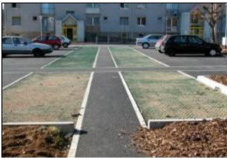
Exemple de parking réservoir à Albi
