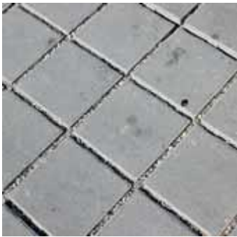
Pavé en béton poreux
