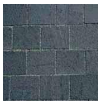
Pavé en dalles de granit : Matériau imperméable ou perméable. Possibilité de rendre la surface revêtue perméable par l'utilisation de joints perméables
