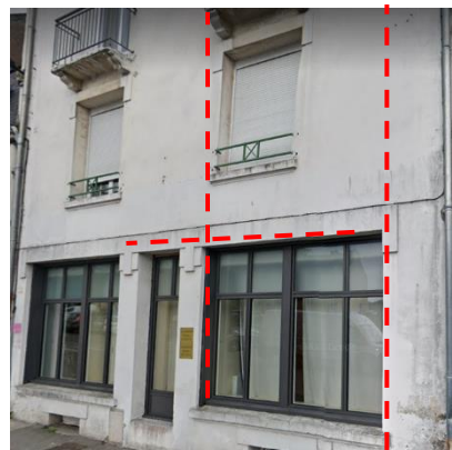
Pas d'alignement entre les ouvertures et percement aléatoire par rapport aux fenêtres (source google street-view)
