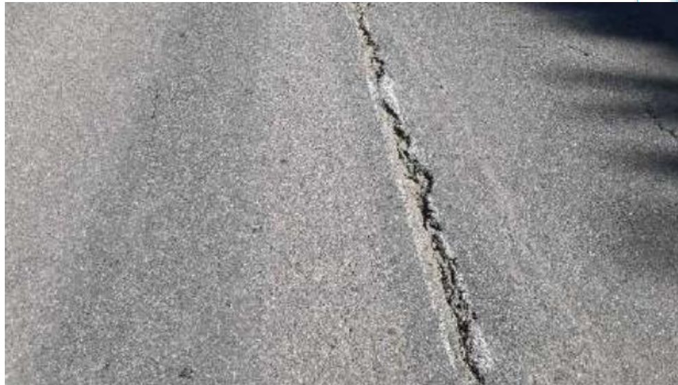
Arrachement granulats au niveau du joint
